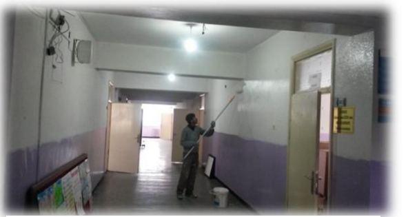
OKUL İÇ KISIM KOMPLE BOYA ÇALIŞMALARI 28.01.2015
