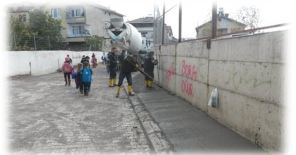
BAHÇE YAN YOL KAPLAMA ÇALIŞMALARI 17.11.2015
